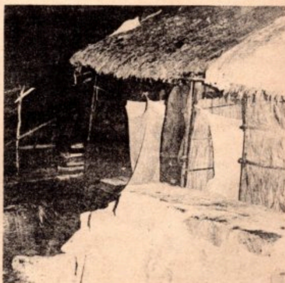
Những nhà lá lụp sụp này sẽ biến thành nhà tươi sáng
