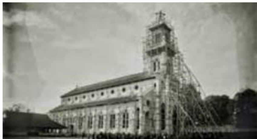
Nhà thờ được trùng tu hoàn thành năm 1929
