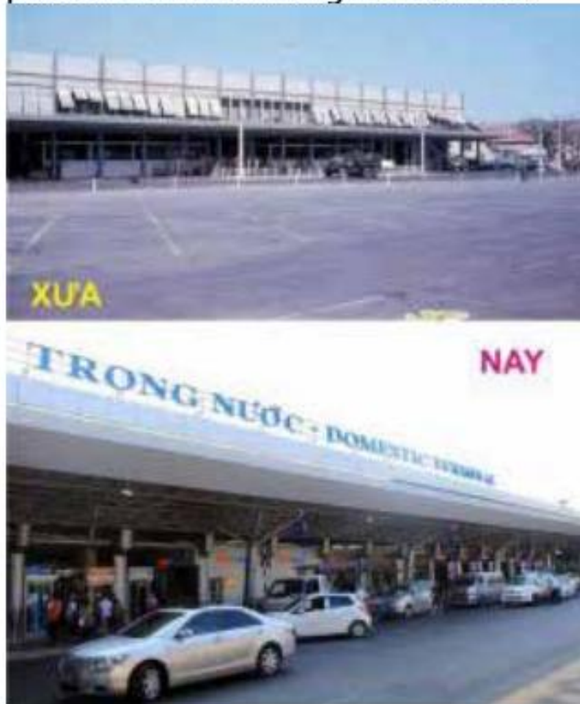
Sân bay Tân Sơn Nhứt được xây dựng vào năm 1933. Sau này ga quốc tế mới được xây dựng
