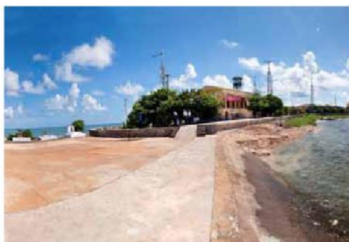
(Xây dựng bến cảng Trường Sa Đông)
