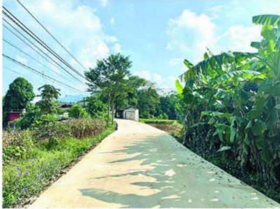
Đường vào xóm Đồng Đình vừa hoàn thành.
