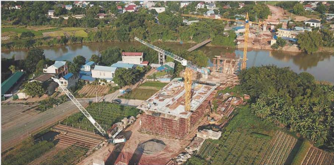
Cầu Huống - một trong những công trình trọng điểm của TP. Thái Nguyên đang được tập trung đẩy nhanh tiến độ thi công. Dự kiến sẽ hoàn thành và đưa vào sử dụng giữa năm 2023. Ảnh: Hoàng Hùng
