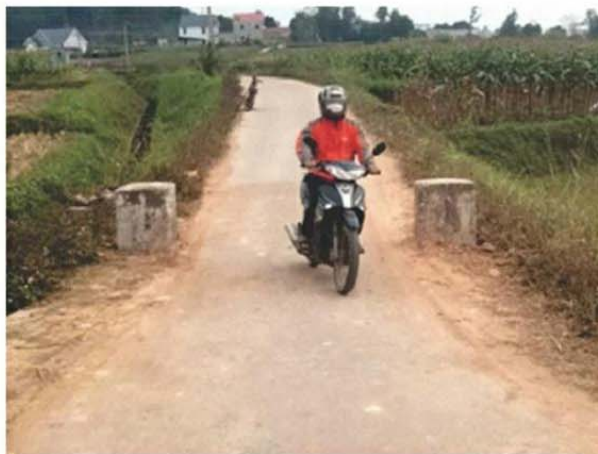
Tuyến đường tại xóm Cũ xã Hà Châu, huyện Phú Bình được người dân lắp đặt hai trụ bê tông từ lâu khiến nhiều ô tô gặp khó khăn mỗi khi đi qua
