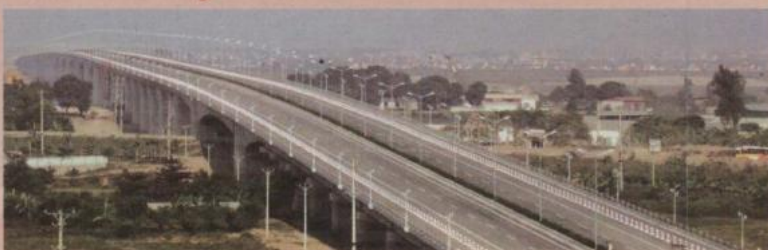
Cầu Thanh Trì - cầu bê tông lớn nhất Đông Nam Á do BJSC12- Cienco1 thi công.
