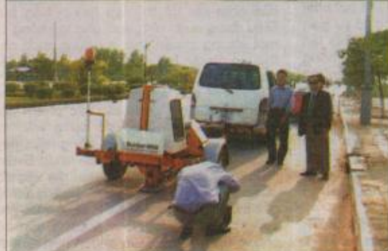
Đo độ bền kết cấu đường bằng Máy Rời chấn động hiện đại
