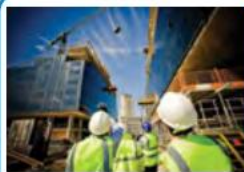
Construction 공사 Công trình
