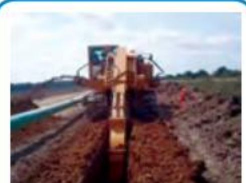
Trenching 흙을 파다 Sự đào rãnh
