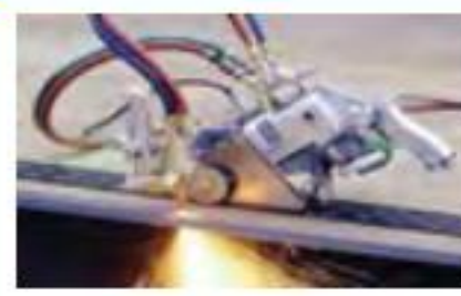
Automatic gas cutting 자동가스 절단 Cắt vật liệu bằng khí gas( tự động)
