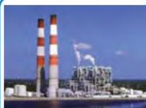
Power plant 발전소 Nhà máy điện
