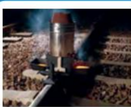
Thermit welding 테르밋 용접 Hàn nhiệt nhôm
