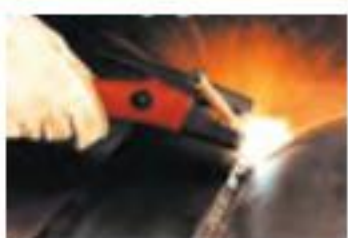
Arc air gouging 아크 에어 가우징 Loại bỏ kim loại bằng hồ quang và áp suất không khí
