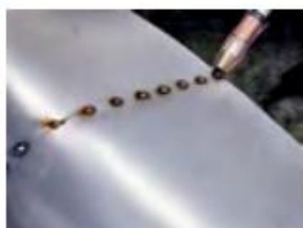
Tack welding 가 용접 Hàn đính
