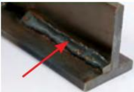
Chân đường hàn không đúng
