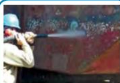
Grit blasting 그리트 블라스팅 Sự tẩy sạch bằng phun cát
