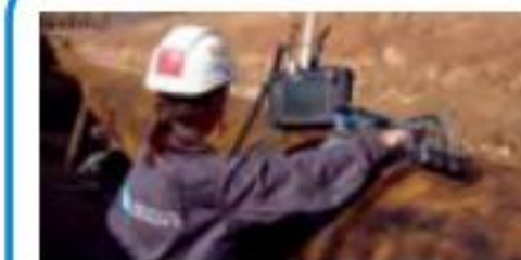
Nondestructive inspection (NDI) 비파괴 검사 Kiểm tra không phá hủy
