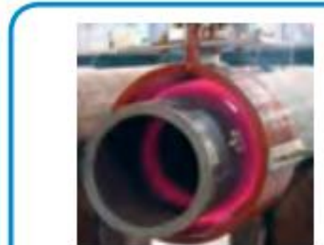
Stress relieving 응력 제거 Khử ứng lực
