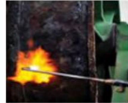
Flame cleaning 불꽃 청소 Làm sạch bằng lửa
