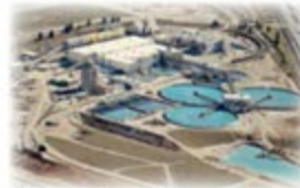
Nước sinh hoạt bẩn được làm sạch cặn bẩn tại nhà máy xử lý nước thải, cho đến khi đủ tiêu chuẩn đưa trở lại vào hệ thống nước.
