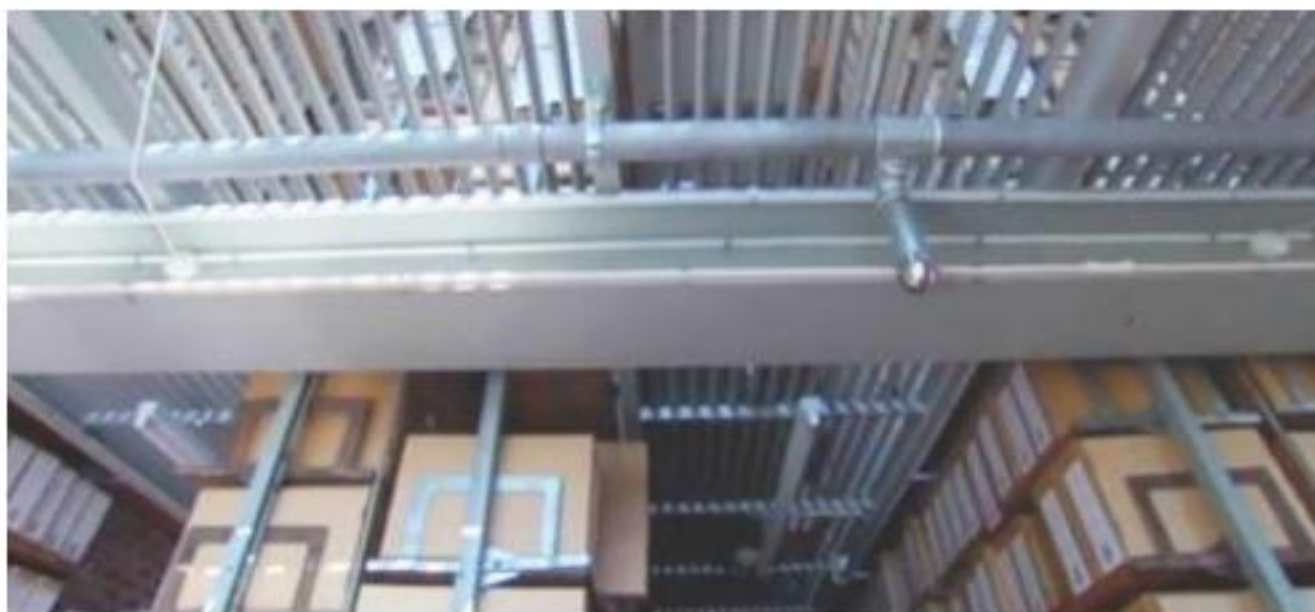
Hệ thống chữa cháy bằng nước
