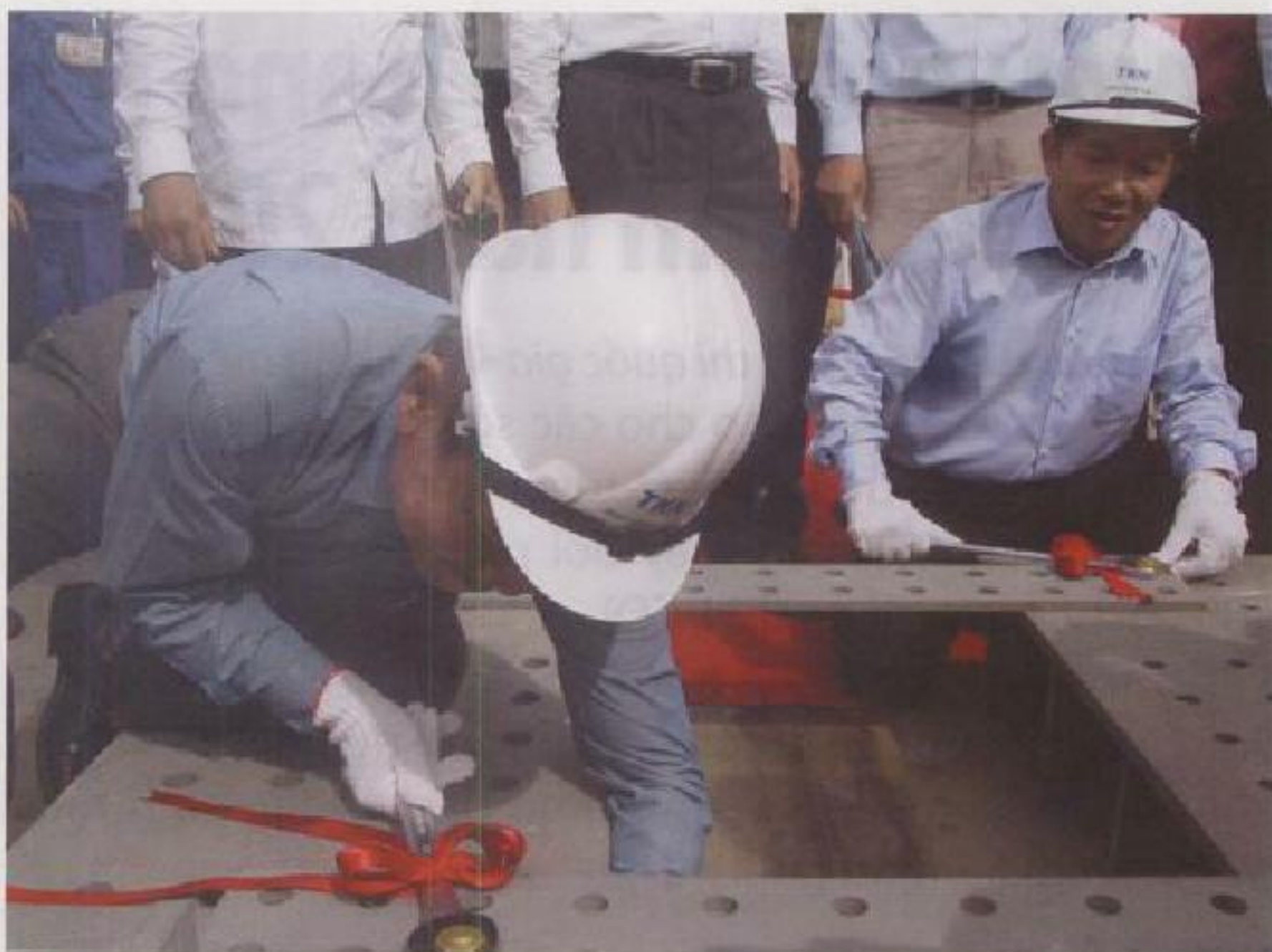
■ Đại diện lãnh đạo TP. Cần Thơ cùng chủ dự án và nhà thầu xây dựng đã siết bulông cố định bao hiệu cầu Cần Thơ được thông suốt. Ảnh: Nguyễn Ngọc
