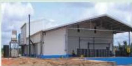
► Nhà Giết Mổ | Nigeria
