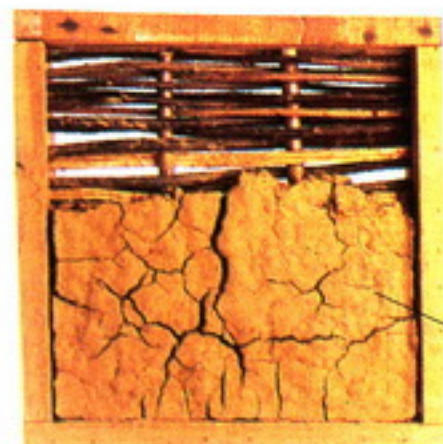
Vữa, một hỗn hợp của rơm, bùn và phân, dùng để đắp tường
