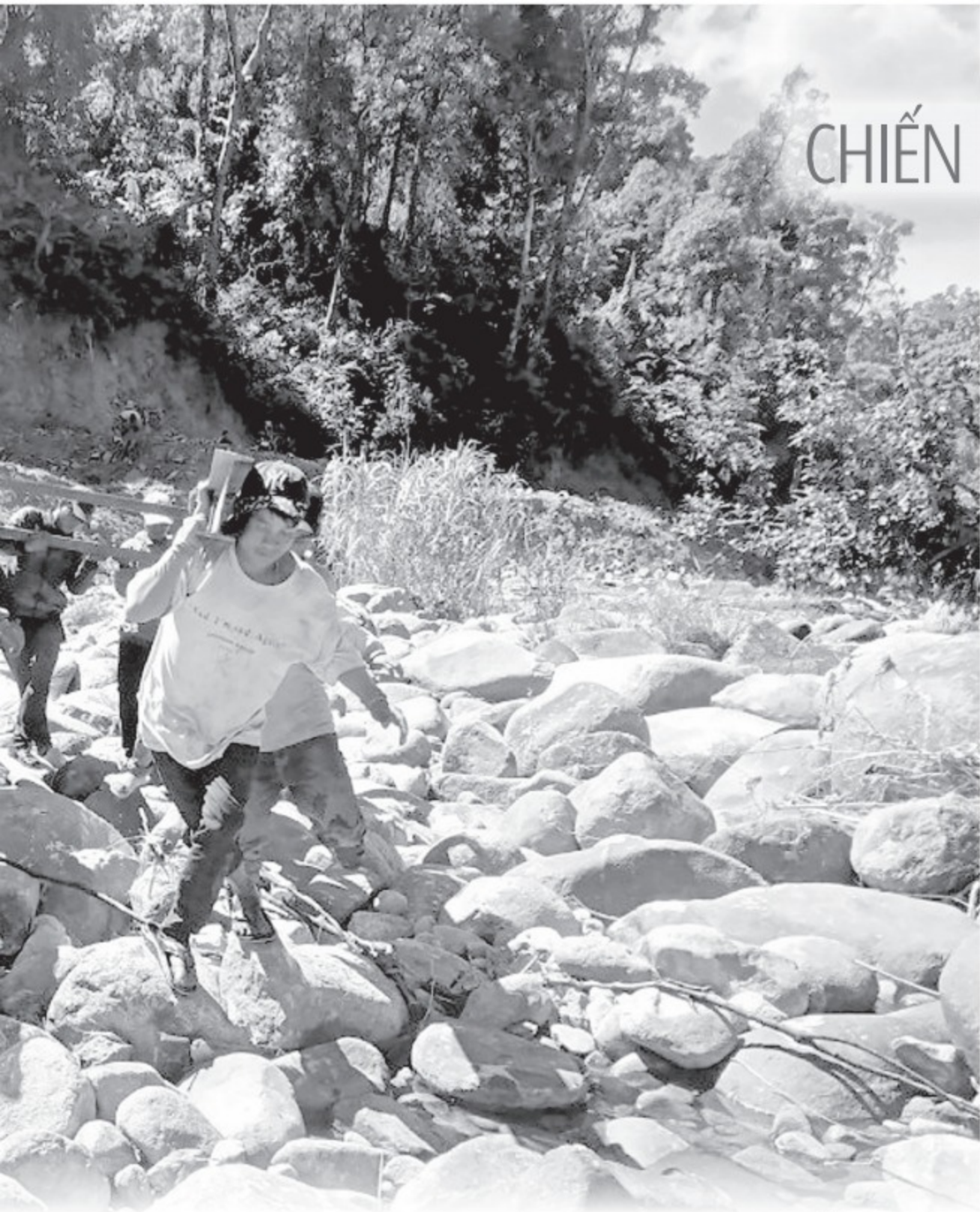
"Biệt đội" gửi công vận chuyển vật liệu xây dựng cầu treo
