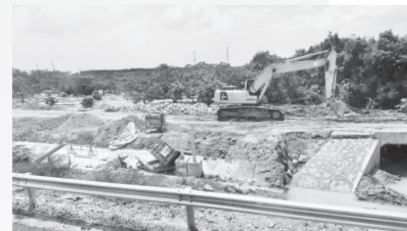
Đường dân sinh hai bên cao tốc Vĩnh Hảo - Phan Thiết thi công chậm
