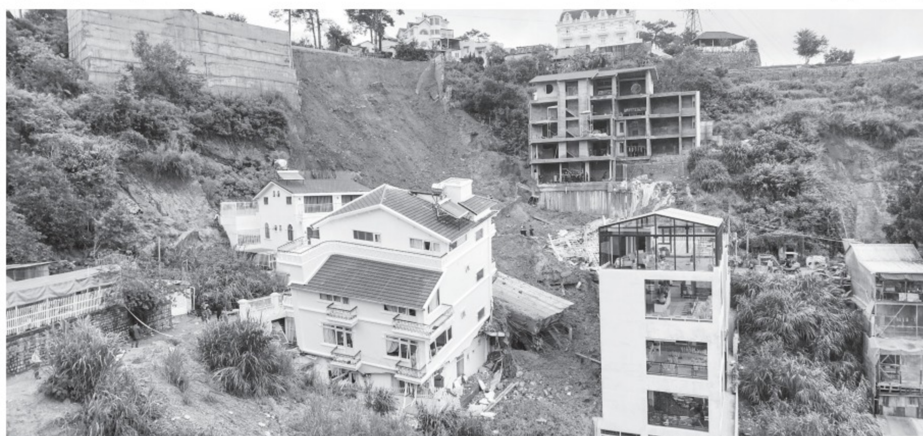
Toàn cảnh hiện trường sạt trượt đất và bờ kè
