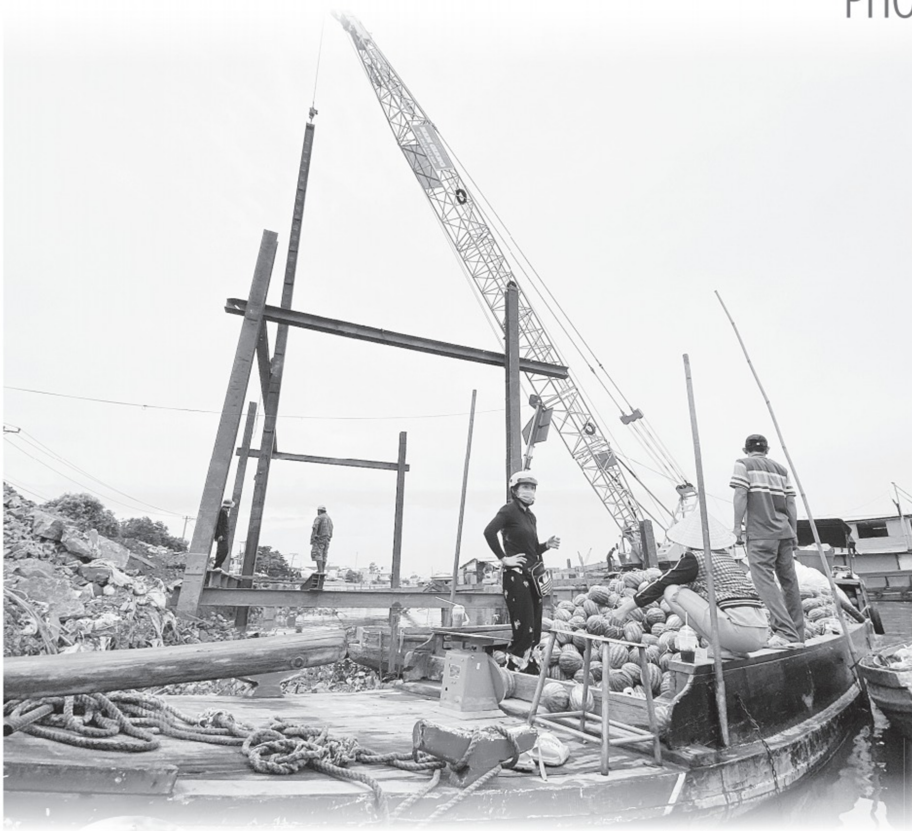
Ghe đưa hẩu tấp vào chỗ trống của công trình bờ kè để lên hàng ở khu vực bến mù u xưa
