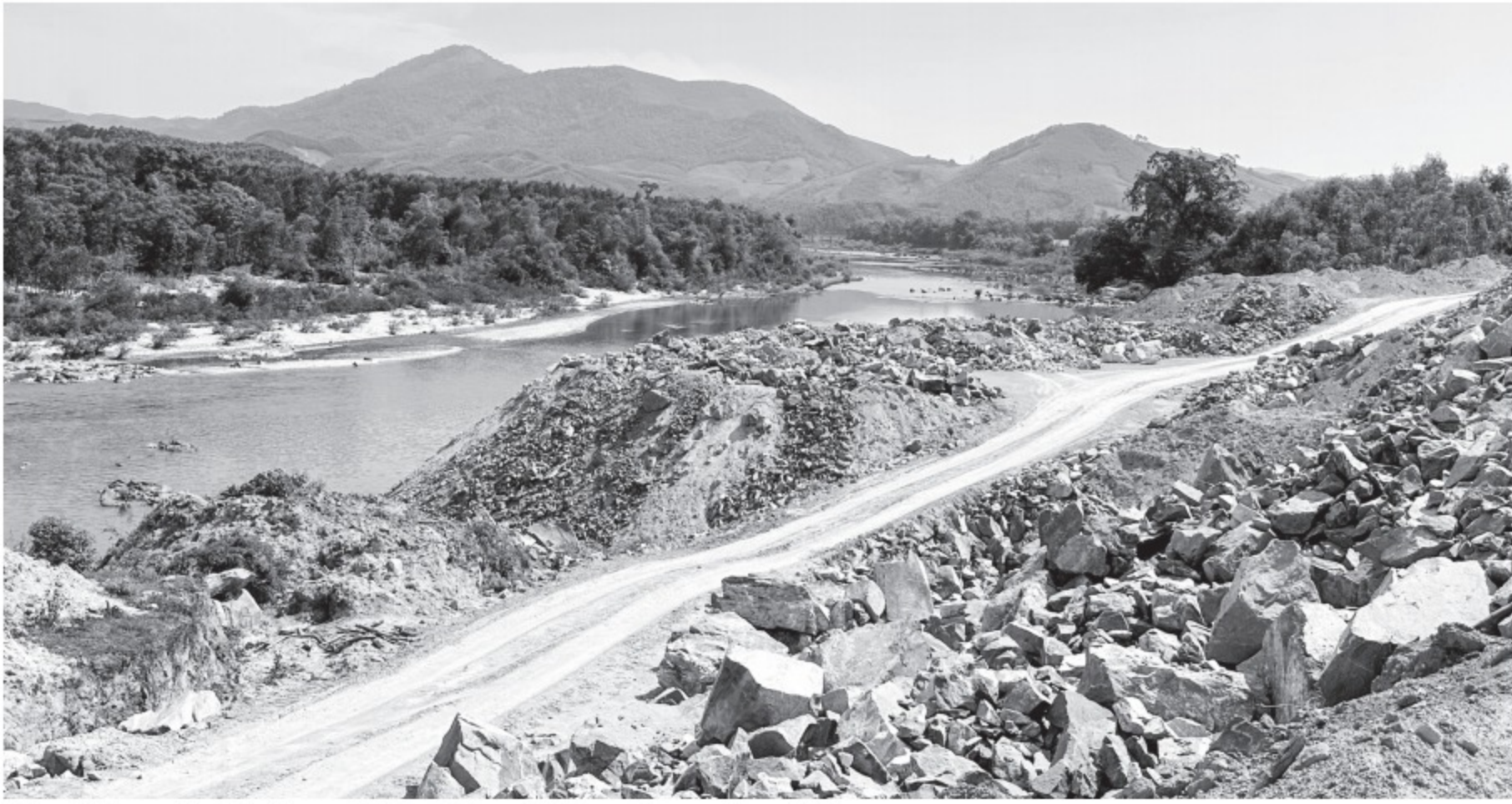
Vị trí đơn vị thi công đổ 9.000 m 3 đất, đá ra sông Liên
