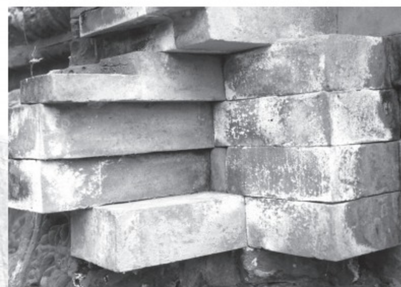
Sau trùng tu khoảng nửa năm, gạch tháp Chăm Khương Mỹ đã xuất hiện tình trạng “muối hóa”
