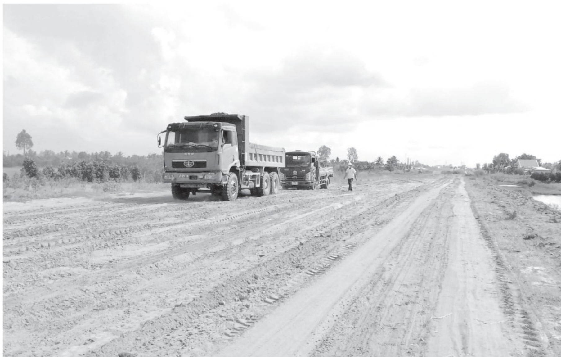
Hiện trạng thi công tuyến cao tốc Mỹ Thuận - Cần Thơ, đoạn qua H.Châu Thành, Đồng Tháp
