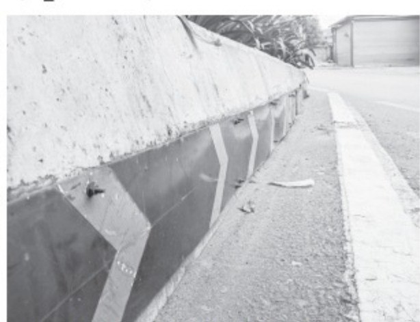
Dây đinh vít chĩa đầu nhọn ra ngoài (trái) và tấm thiếc phản quang bị bung ra gây nguy hiểm
