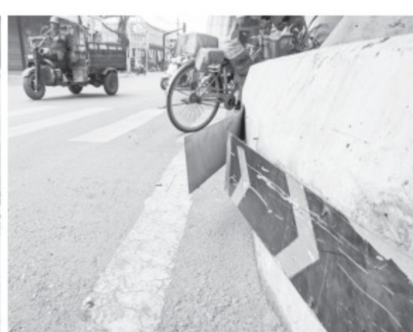
Dây đinh vít chĩa đầu nhọn ra ngoài (trái) và tấm thiếc phản quang bị bung ra gây nguy hiểm
