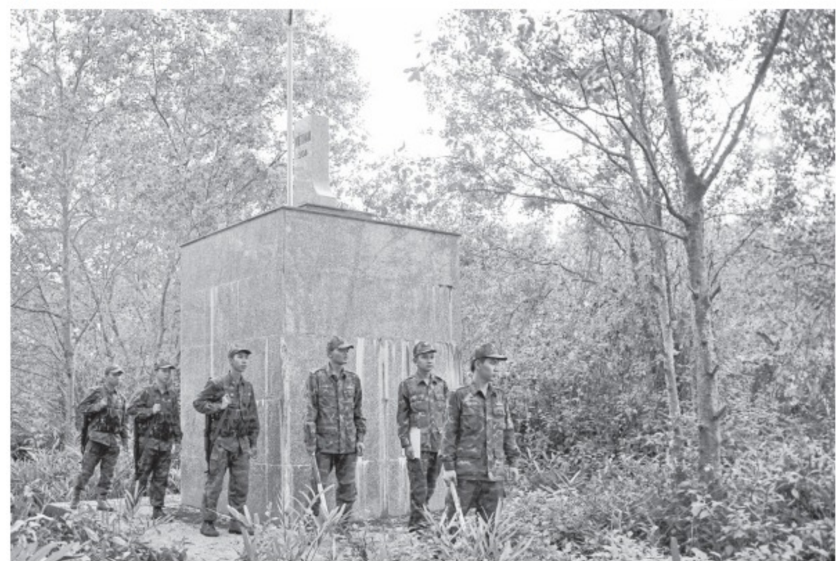
Do nằm ở vị trí trũng, bị ngập nước vào mùa mưa, nên mốc 304 ở Kiên Giang được thiết kế đặc biệt với phần bệ mốc cao gần 5 m, để tránh việc cột mốc bị ngập nước, hư hại ẢNH: MAI THANH HẢI
