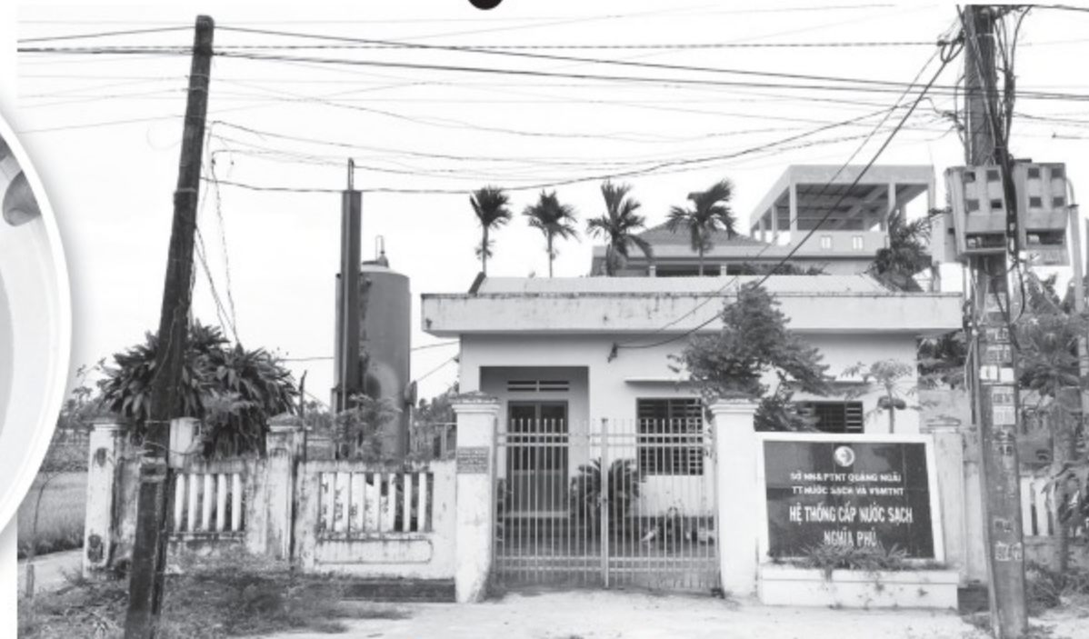
Hệ thống cấp nước sạch xã Nghĩa Phú
