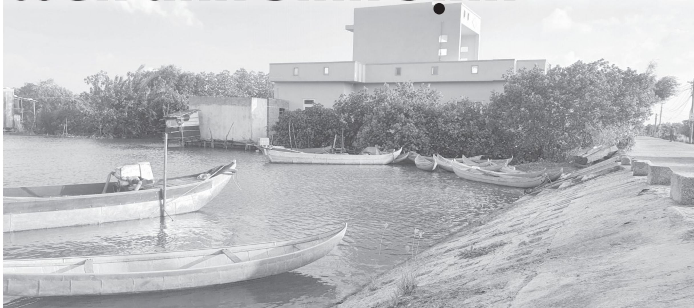
Một số công trình kiên cố xây dựng trái phép ở khu vực đê Đông
