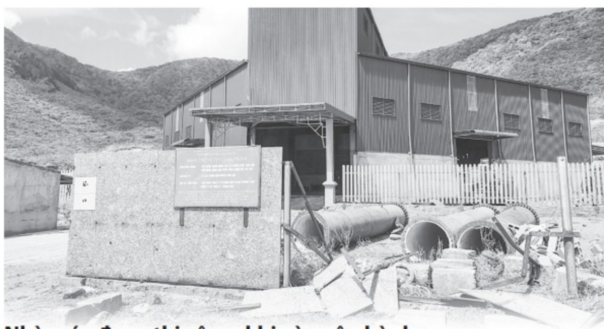
Nhà máy đang thi công, khi vào vận hành sẽ đốt 80 tấn rác/ngày
