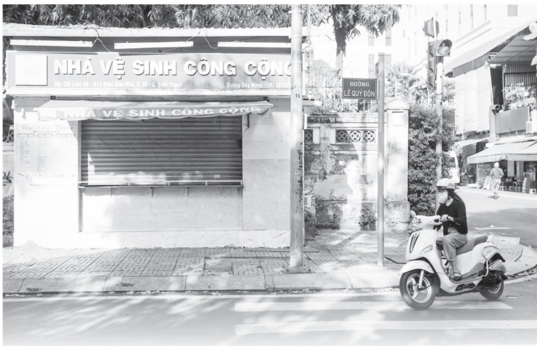
TP.HCM đang lên kế hoạch nâng cấp nhà vệ sinh công cộng của thành phố
