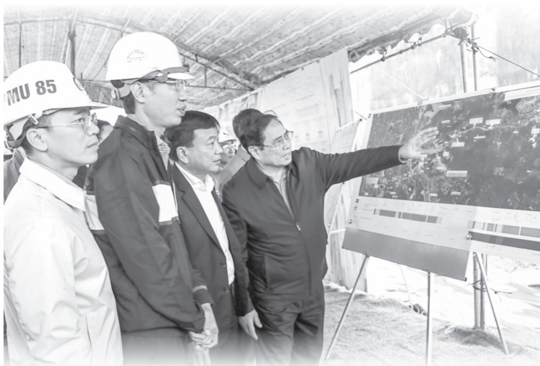
Thủ tướng thăm công trường dự án cao tốc Bắc - Nam đoạn qua Phú Yên
