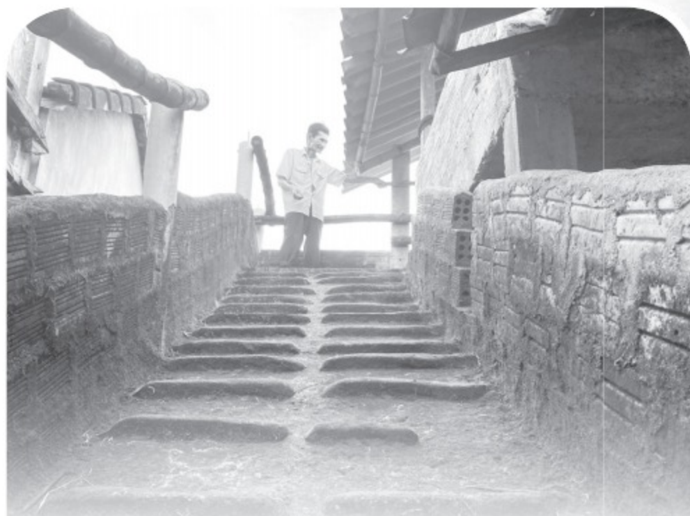
Đường dẫn bê tông để gia súc đi lên tầng tránh lũ
