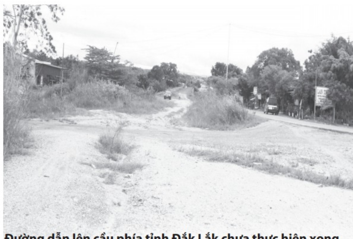
Đường dẫn lên cầu phía tỉnh Đắk Lắk chưa thực hiện xong giải phóng mặt bằng
