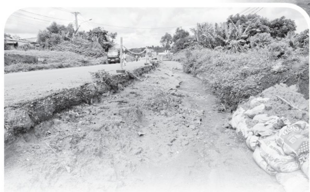
Thời điểm các nhà thầu thi công trong mùa mưa đã ảnh hưởng đến giao thông, dân sinh
