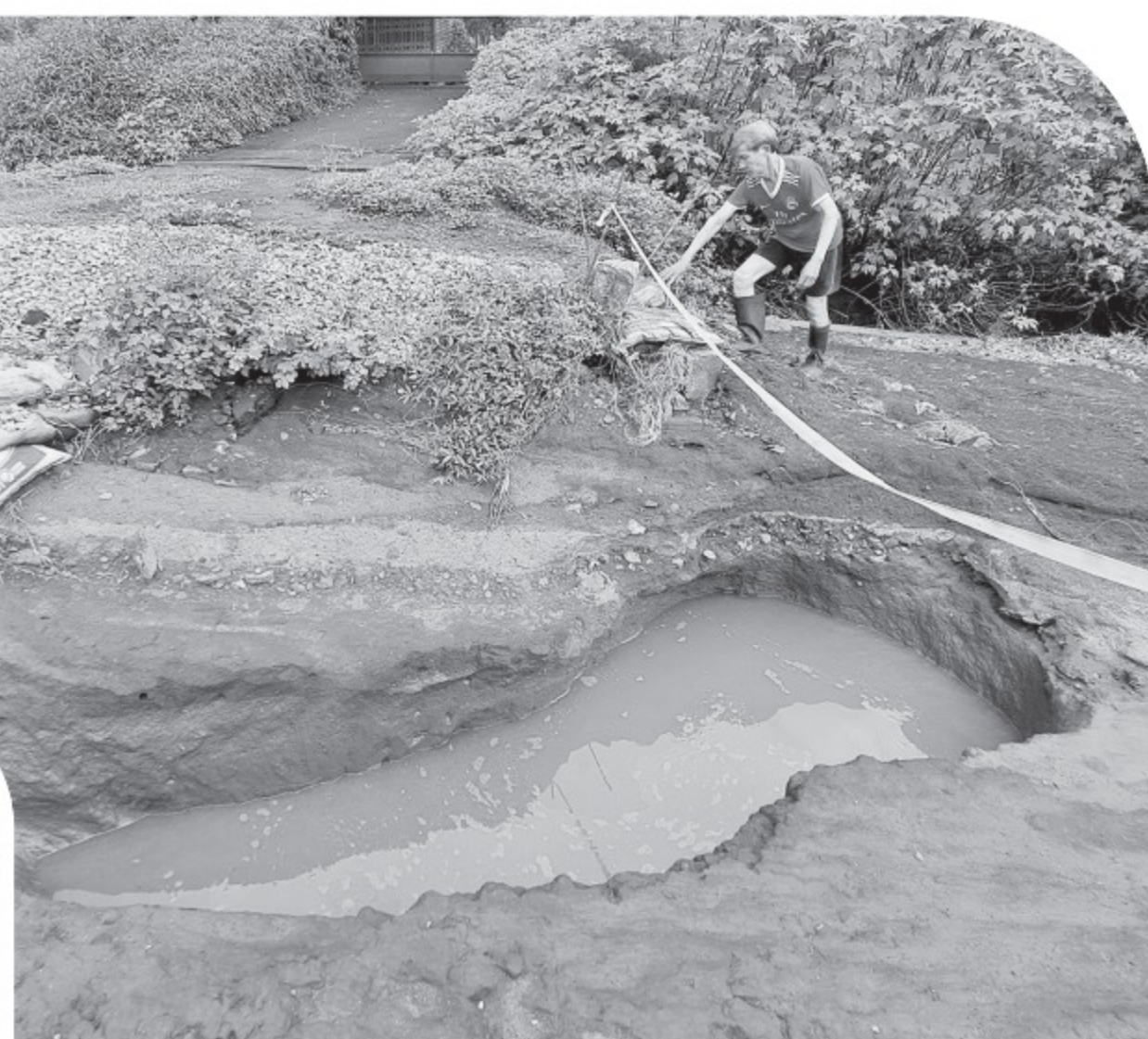
Nhà dân bị chặn lối đi vì đơn vị thi công đào đường
