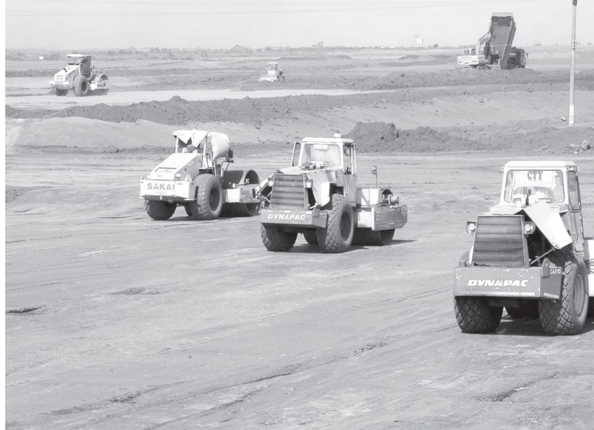
Đào đắp, san nền tại dự án Cảng hàng không quốc tế Long Thành tháng 12.2022. ẢNH: LÊ LÂM
