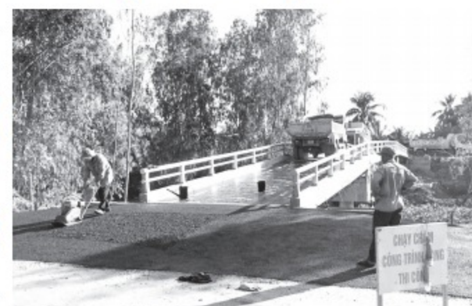
Cầu 3/2 đang hoàn thiện những công đoạn cuối cùng
