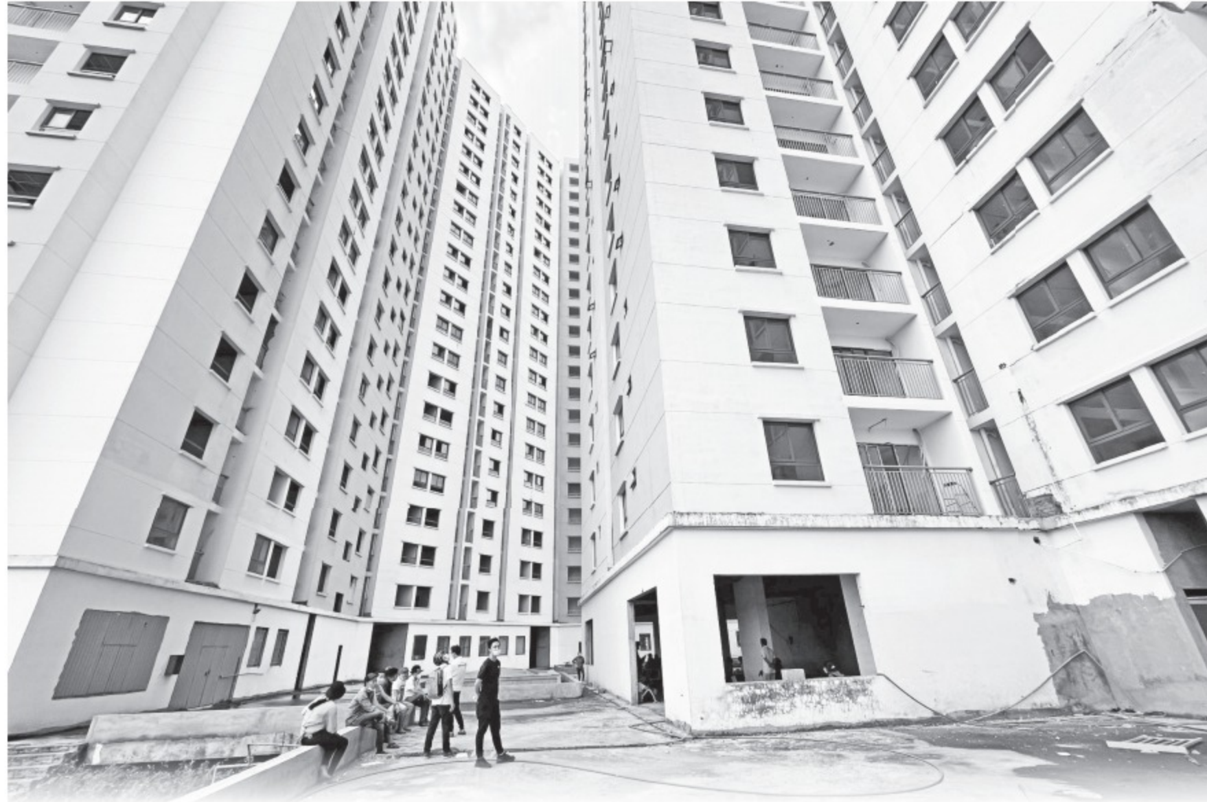
Một dự án nhà ở xã hội tại Q.Bình Tân (TP.HCM) đang xây dựng nhưng chậm tiến độ so với cam kết
