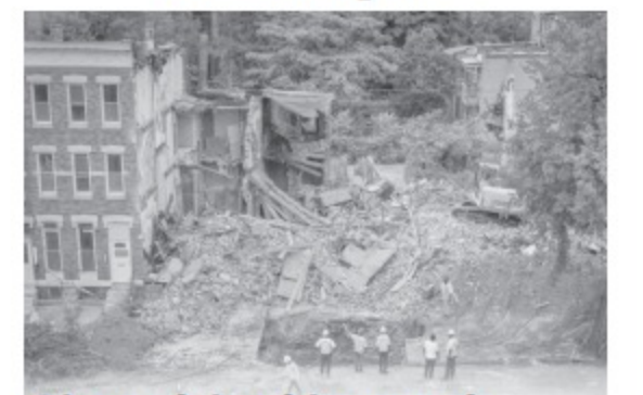
Công nhân đứng cạnh miệng hố trước các ngôi nhà bị phá dỡ
