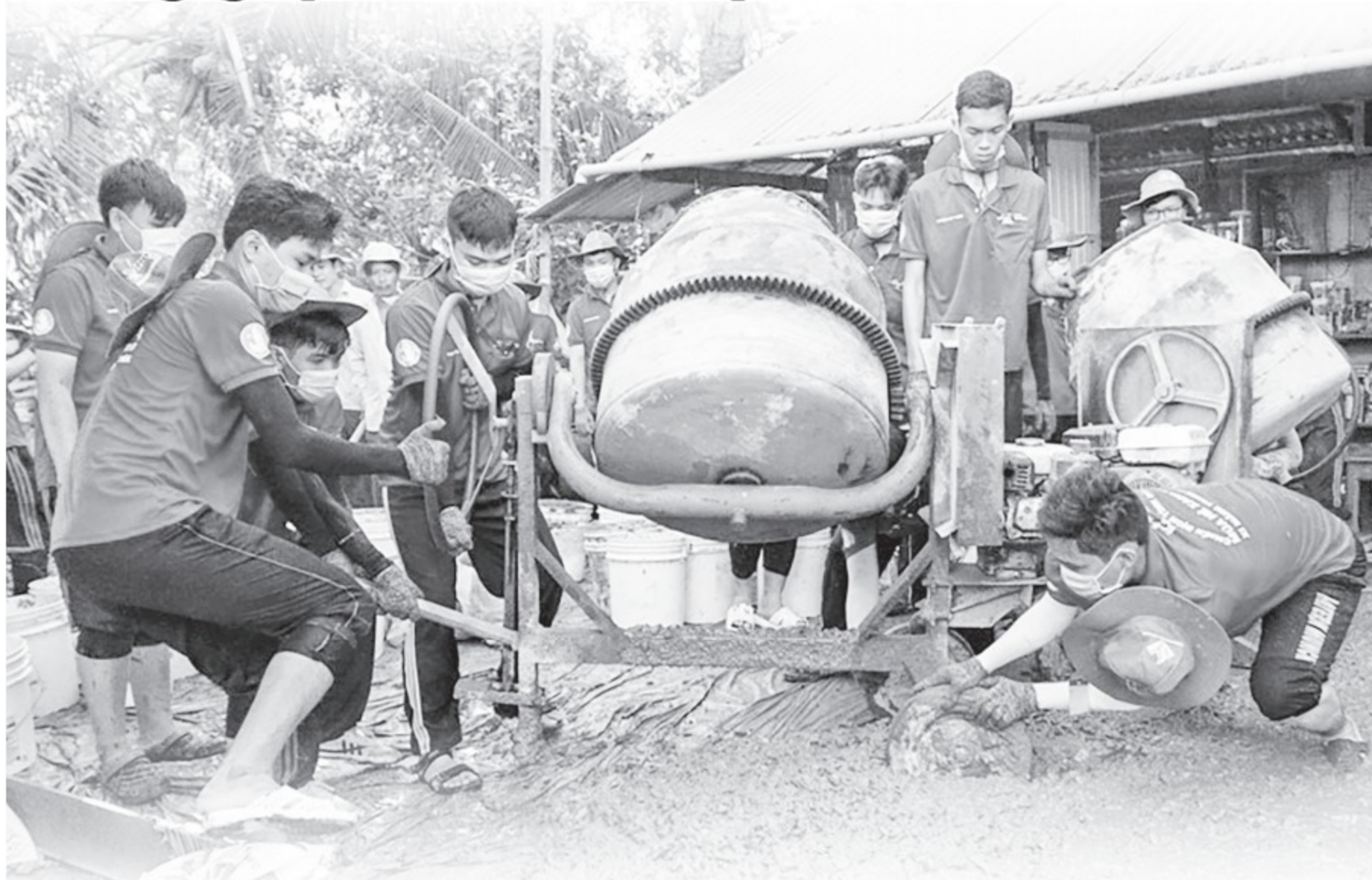
Sinh viên Trường ĐH Bách khoa TP.HCM xây dựng đường bê tông nông thôn trong chiến dịch Thanh niên tình nguyện hè
