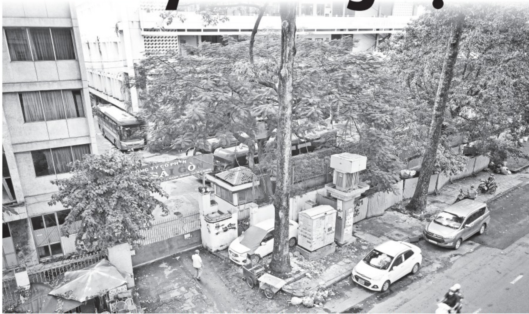
Khu đất 419 Lê Hồng Phong, P.2, Q.10 (TP.HCM) hết hạn thuê đất từ cuối năm 2020 nhưng doanh nghiệp chưa bàn giao lại cho nhà nước xây dựng trường học công lập ẢNH: NGỌC DƯƠNG
