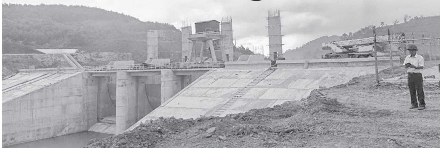
Một hạng mục đang được thi công tại dự án hồ Krông Pách thượng
