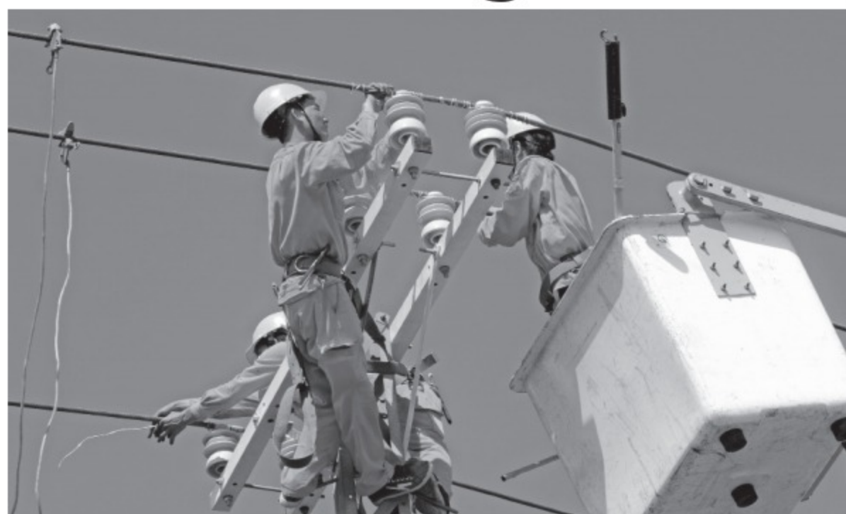
Các công nhân sửa chữa, bảo trì lưới điện ẢNH: HOÀNG KHÔI
