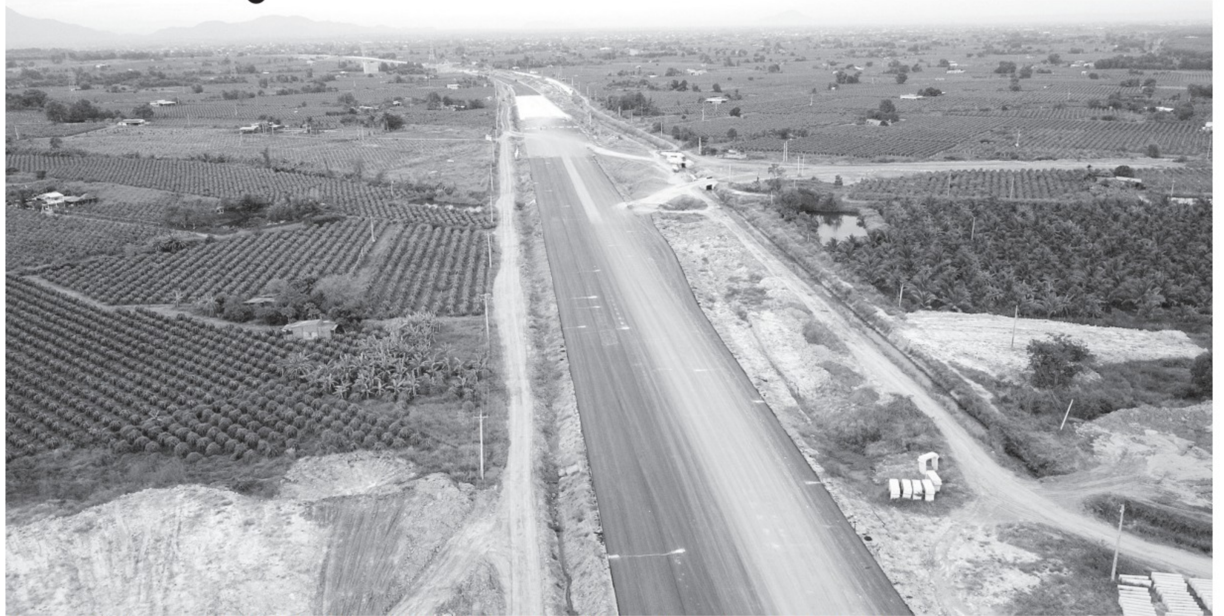
Đoạn cuối của cao tốc Vĩnh Hảo - Phan Thiết (xã Hàm Kiệm, H.Hàm Thuận Nam, Bình Thuận)
