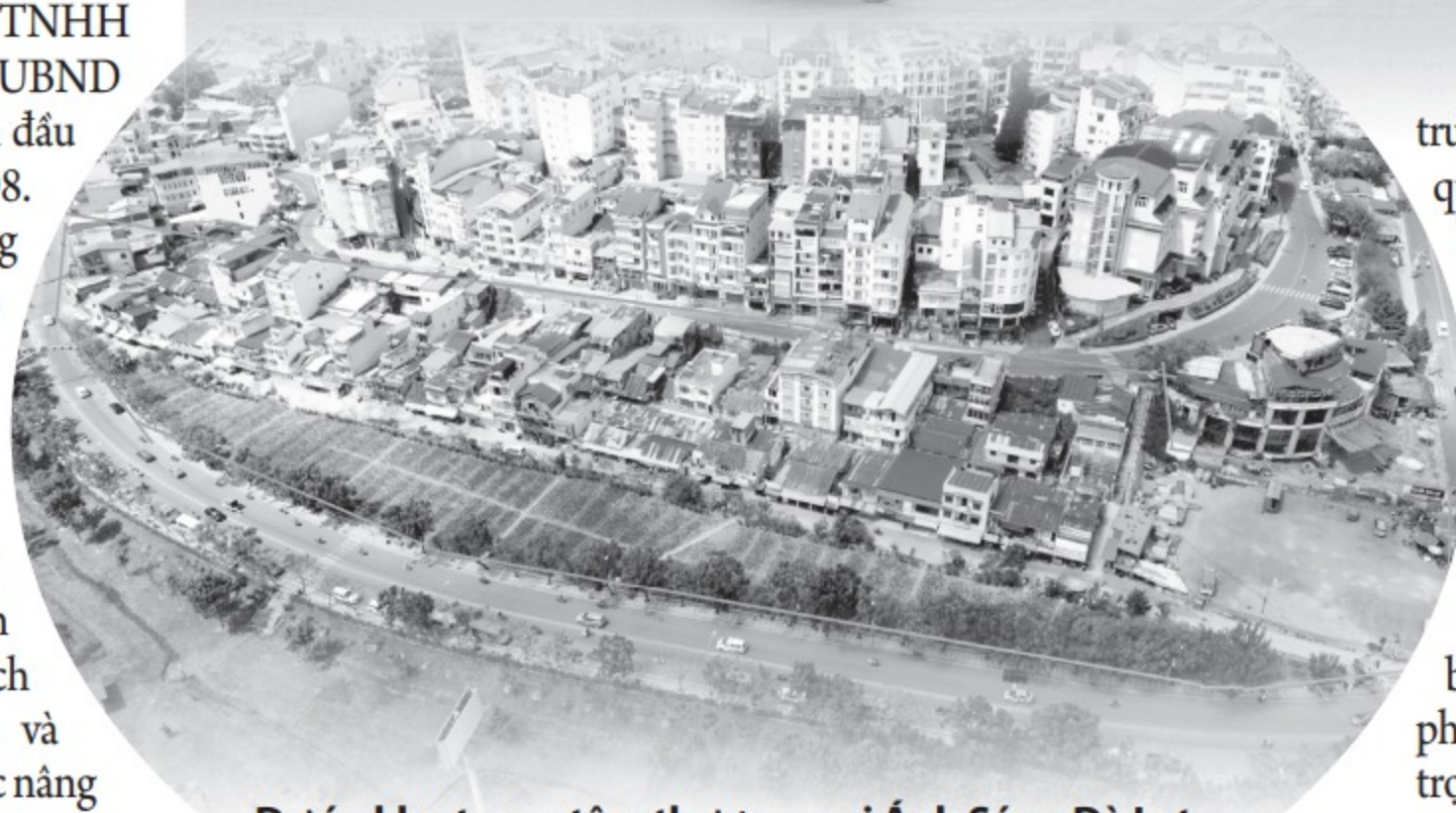
Dự án khu trung tâm thương mại Ánh Sáng Đà Lạt 15 năm vẫn đang “đóng băng”
