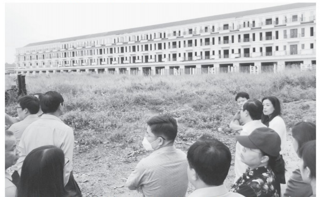
Dự án khu dân cư Bình Đa đã xây dựng gần như hoàn thiện 2 dãy nhà phố ẢNH: LÊ LÂM
