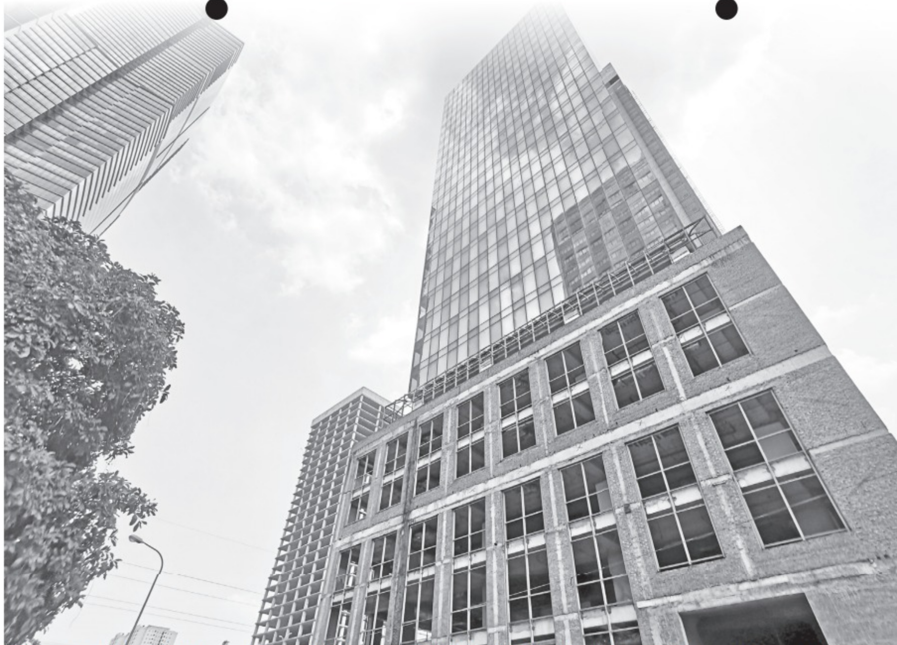
Công trình tòa nhà Apex Tower bỏ hoang trên khu “đất vàng” ở ven đường Phạm Hùng
