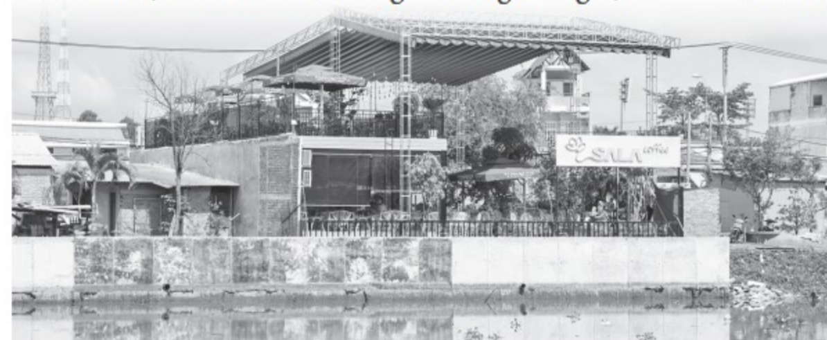
Mặt hậu quán cà phê Sala nằm hoàn toàn trong khu vực DA bờ kè Bảo Định
