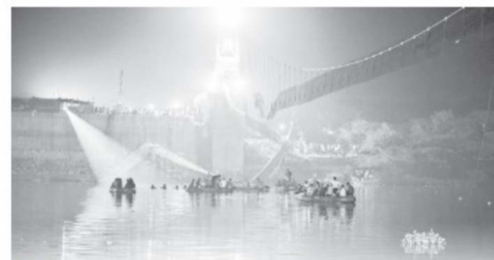
Hiện trường vụ sập cầu
