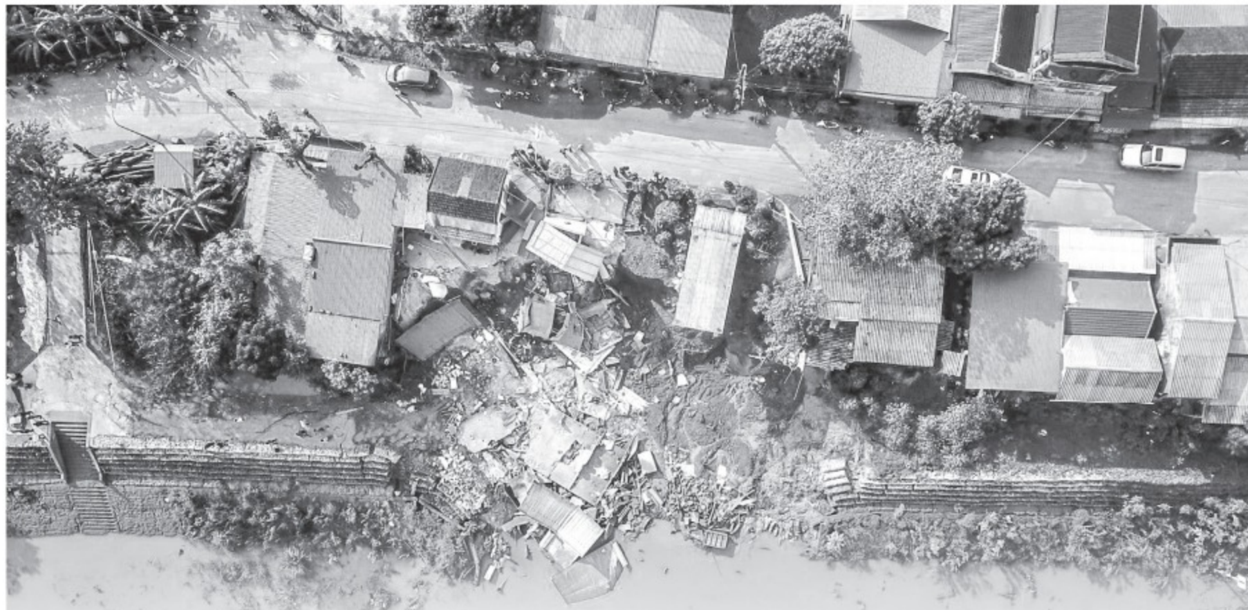
Nhiều nhà dân vẫn ở ven bờ có nguy cơ sạt lở dọc sông Thạch Hãn tại thôn Như Lệ
