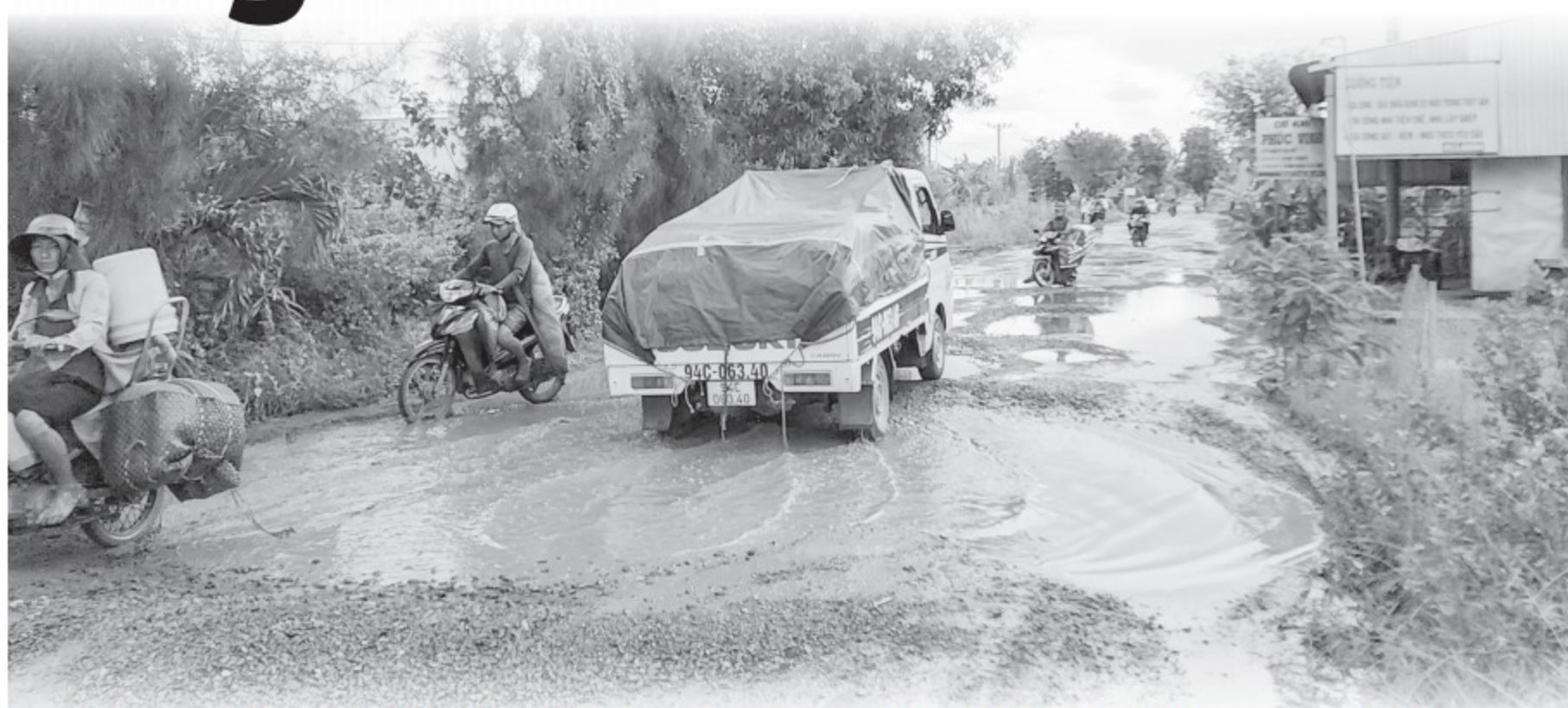
Mặt đường chằng chịt ổ voi, nước đọng thành vũng lớn, tiềm ẩn nhiều nguy cơ tai nạn giao thông
