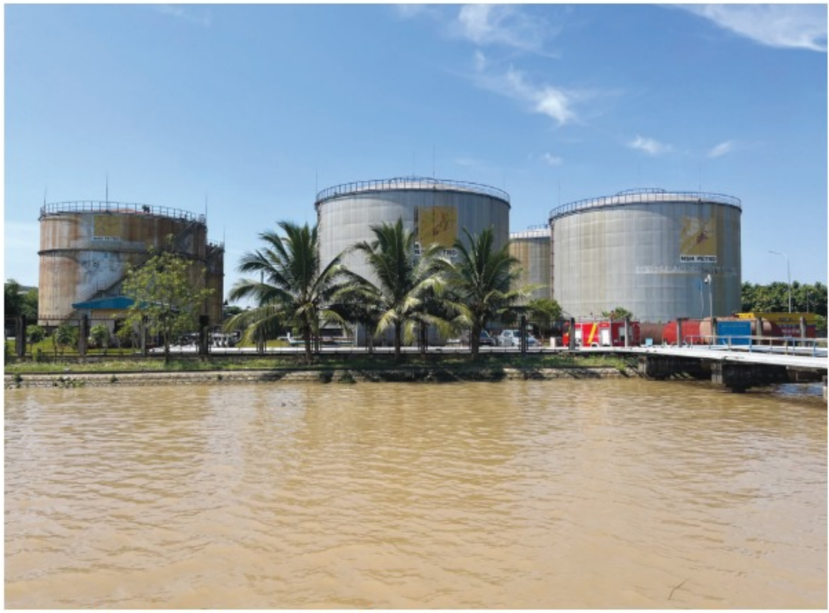
Hệ thống bồn chứa xăng dầu của NSH Petro
