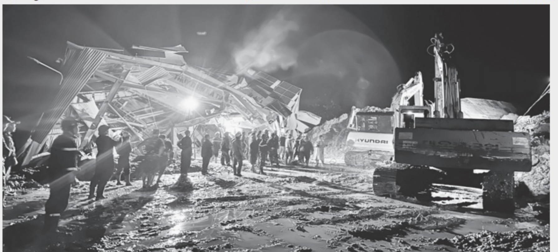
Dùng máy đào để tìm kiếm kỹ sư thủy điện mất tích ở Nhà máy thủy điện Cà Tinh (H.Trà Bồng, Quảng Ngãi) ẢNH: T.ĐỨC
