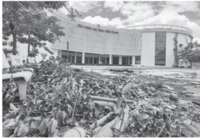
Công trình Nhà thiếu nhi tỉnh Tiền Giang được đầu tư hơn 126 tỉ đồng từ ngân sách, bị bỏ hoang phế, nhếch nhác sau hơn 3 năm đưa vào hoạt động
