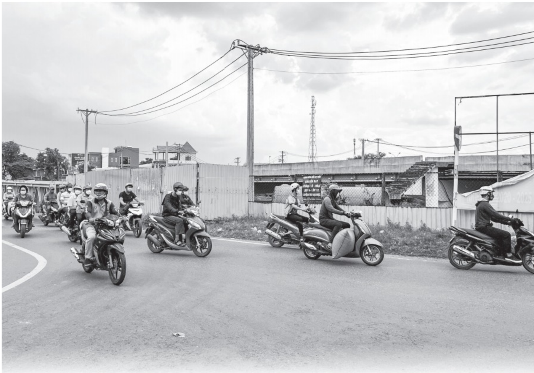
Cầu Tân Kỳ - Tân Quý đã đạt 70% khối lượng thi công và hiện đang tạm dừng
